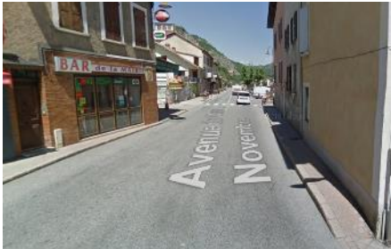
Photographies : problèmes de sécurité et accessibilité PMR le long de la D942 (source : googlemaps)
