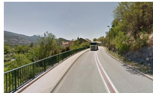
Entrée nord depuis Lettret cadrée par les reliefs de la Tour à l'ouest et les jardins des berges de la Durance à l'est
