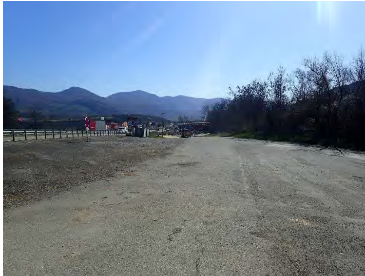
Elargissement de la voirie au niveau de l'ancienne voie de décélération - Source : Alpicité
