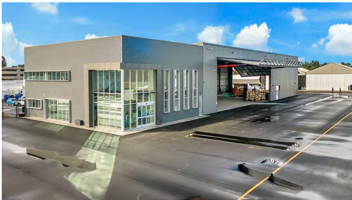
Exemple du futur hangar – Source : ROTORTRADE
