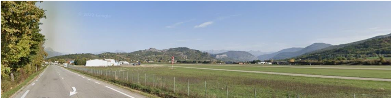
Vue sur la façade sud du bâtiment actuel : pignon aveugle et blanc particulièrement impactant dans le paysage et peu qualitatif
