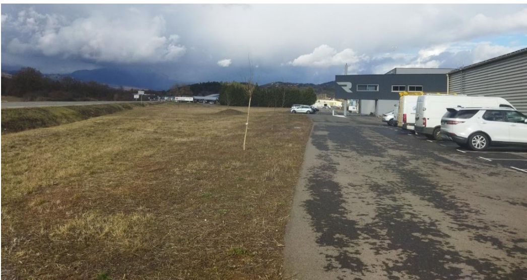
Vue des abords des bâtiments entre le front bâti et la RN85
