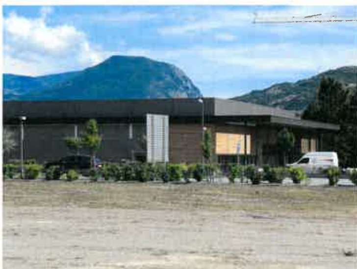
▲ Vue du supermarché et des aménagements paysagers (source Mairie)
