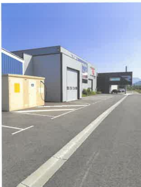
Accès sur site projet ROTORTRADE par rue Pierre-Georges Latécoère
