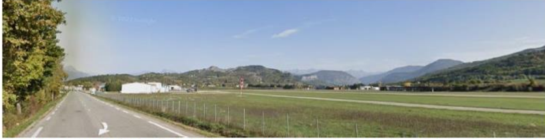
Vue sur la façade sud du bâtiment actuel : pignon aveugle et blanc particulièrement impactant dans le paysage et peu qualitatif
